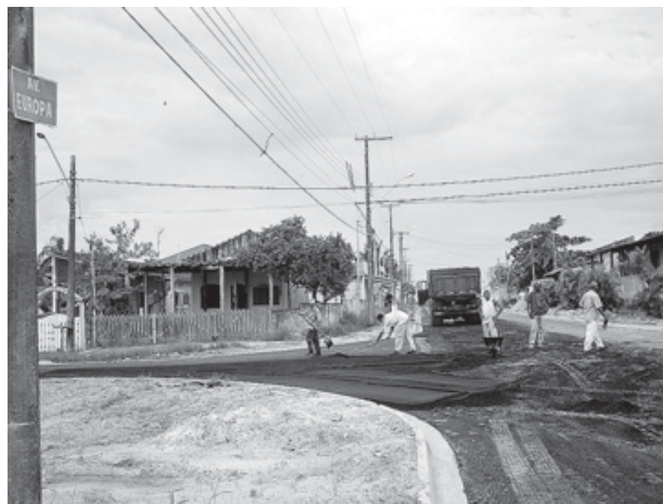
As obras feitas através do PCM consistem na realização da pavimentação de ruas...
