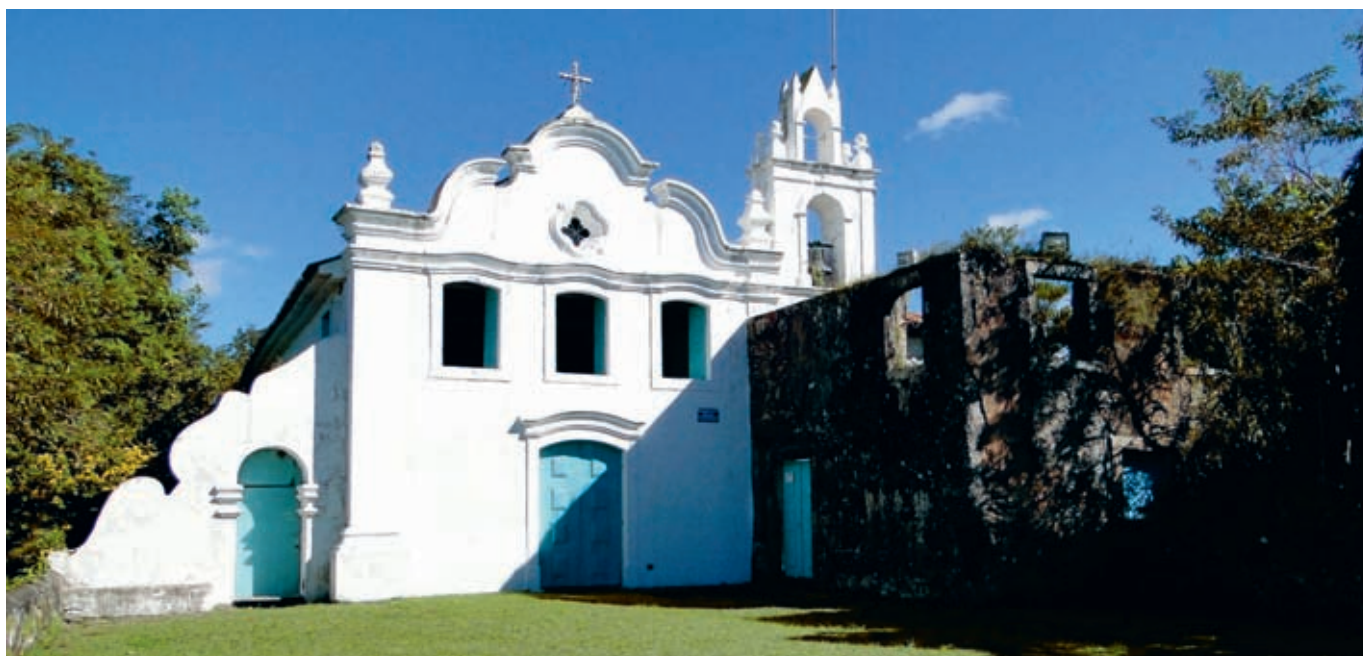
Capela e Convento Nossa Senhora da Conceição. Fonte: PMI.
