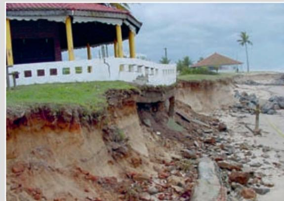
**Foto 2.1-3** - Vista de trecho da orla onde se observa a ação do embate das ondas afetando a estrutura do quiosque. Fonte: PMI.
