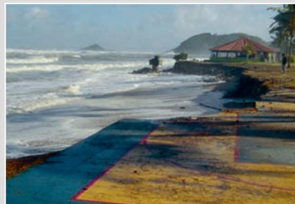
**Foto 2.1-5** - Vista de outro trecho da orla onde se observa a erosão costeira destruindo o calçamento. Fonte: PMI.
